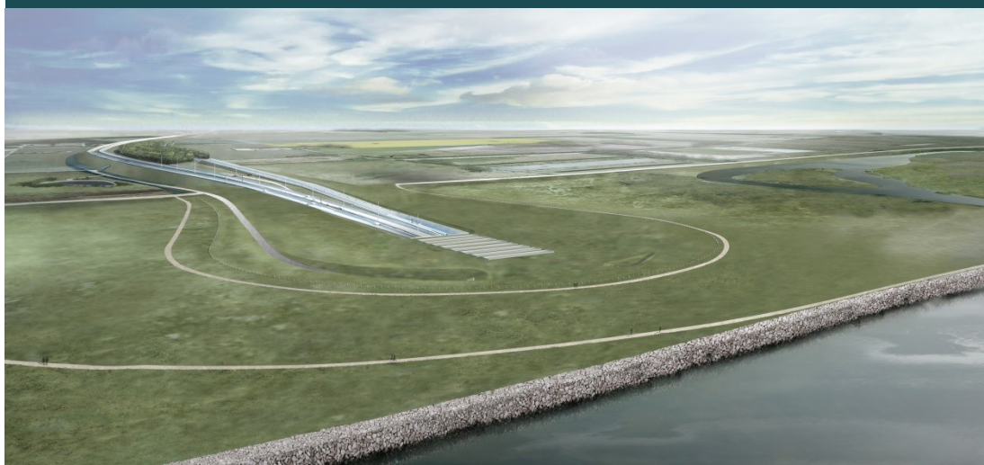
FIGUR 5.13 Portalbygning, Lolland – projektet for sænketunnel, juni 2013
