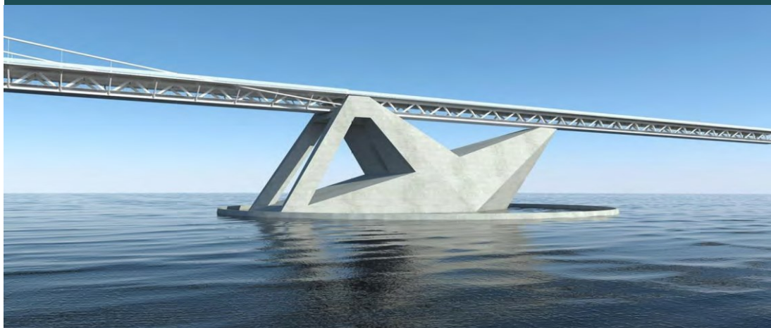
FIGUR 5.45 Principskitse af en ankerblok – hængebro
