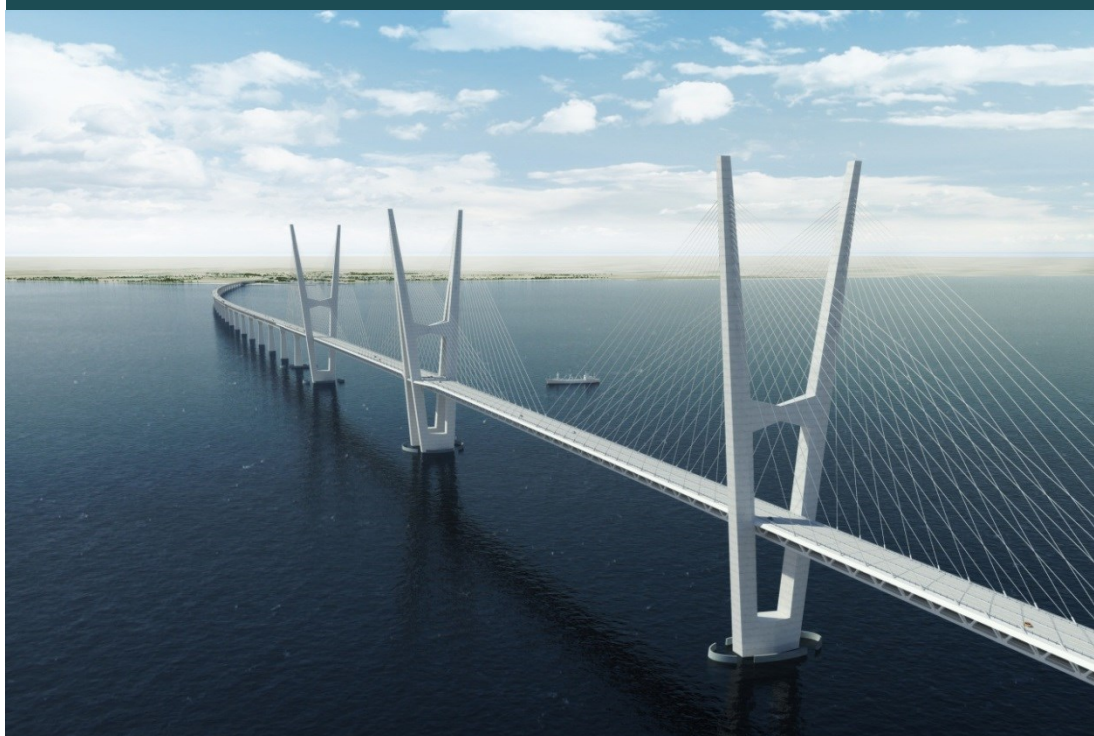
FIGUR 5.18 Principskitse af en skråstagsbro over Femern Bælt
