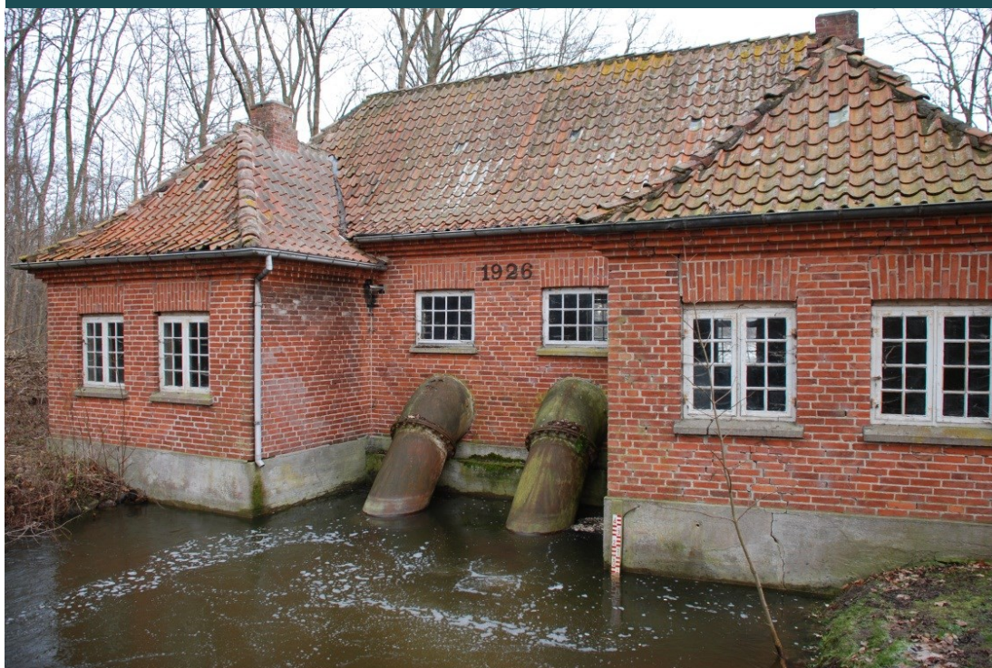
FIGUR 26.11 Pumpestationen mellem Hejrede Sø og Maribo Søundersø
