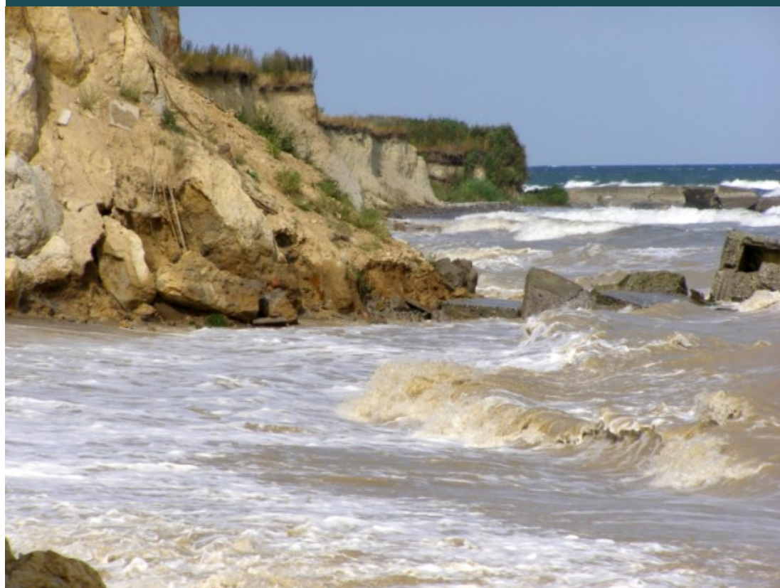
FIGUR 12.5-12 Erosion i en naturlig moræneklint ved Gedser Odde ca. 40 km øst for Rødbyhavn, i en situation med bølgepåvirkning
