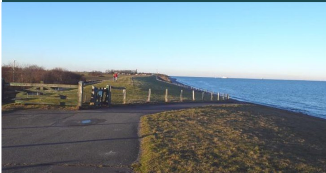
FIGUR 10.1.4-32 Diget, som beskytter det lavtliggende land omkring Presen
