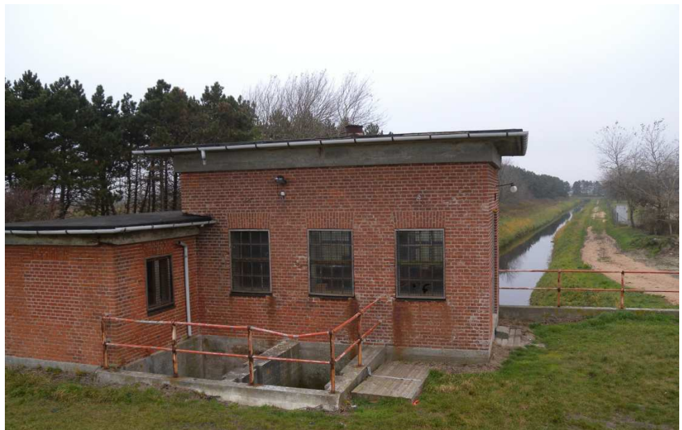
Figur 9.3 Strandholm pumpestation der nedlægges under anlægsfasen.
